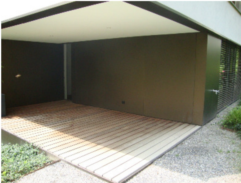
Holzrost. Attenhoferstr. 17, 8032 Zürich (2011)
